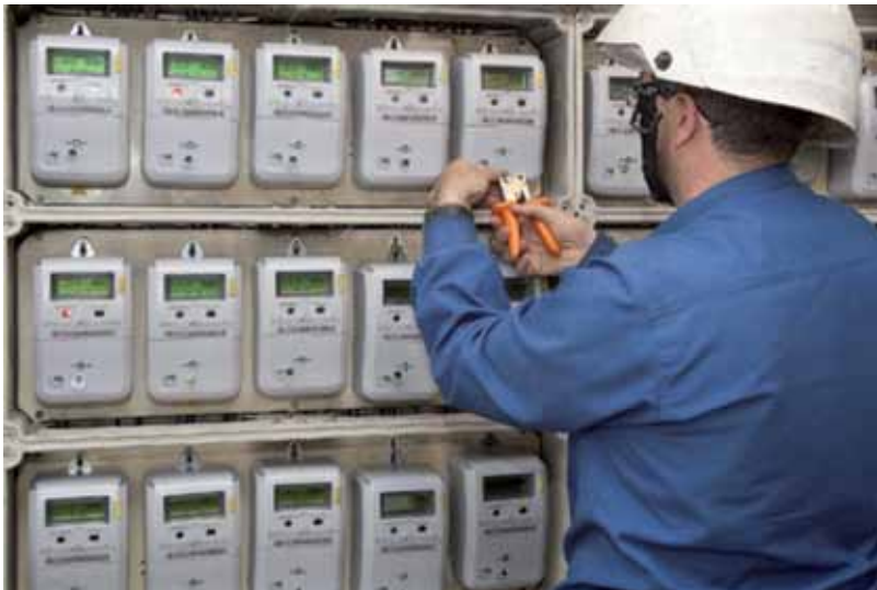
Figura 5.8: Instalación de contadores inteligentes. Fuente: El País.
